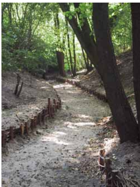
Ryc. 31 i 32. Rzeka Cyganówka – prace regulacyjne koryta (fot. autor)
